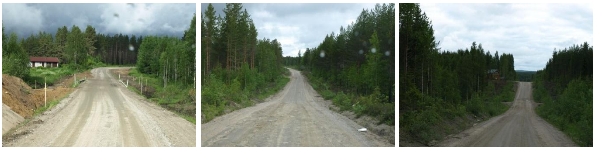
Baustelle auf der 912.
