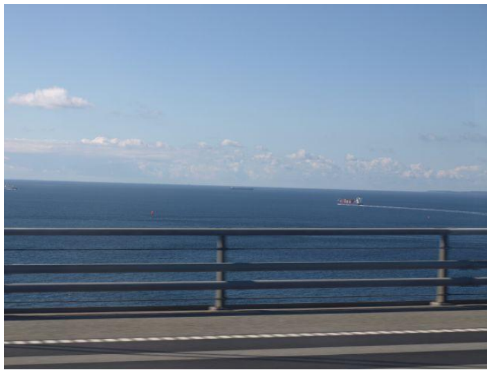
Tief unten ein Containerschiff unter der Brücke.
