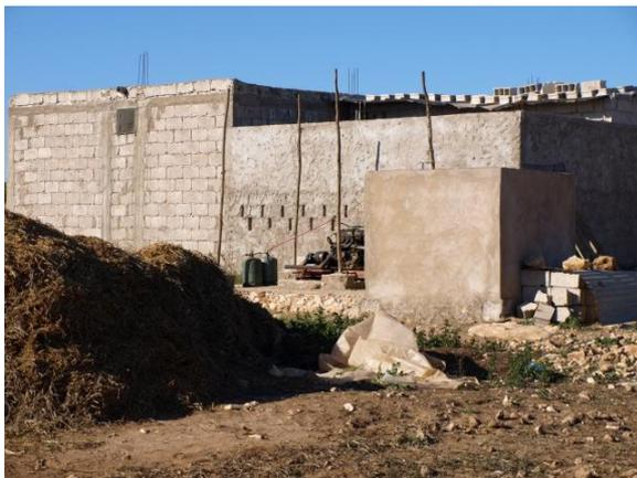
Auf dem nebenstehenden Bild sind zwei Dinge interessant. In der Bildmitte sieht man einen Generator mit dem eine Wasserpumpe betrieben wird. Der Generator wird mit billigem Gas betrieben. Die Gasflaschen sind gut zu erkennen.
