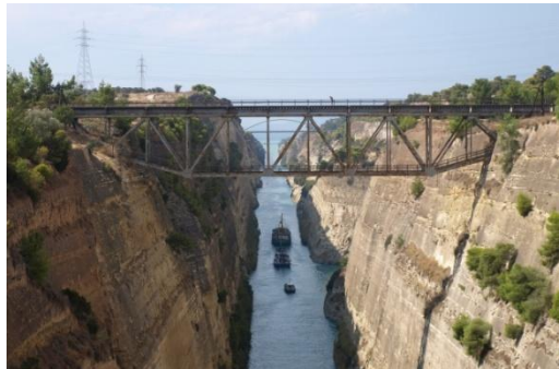
Kanal von Korinth mit der alten Stahlbrücke.
