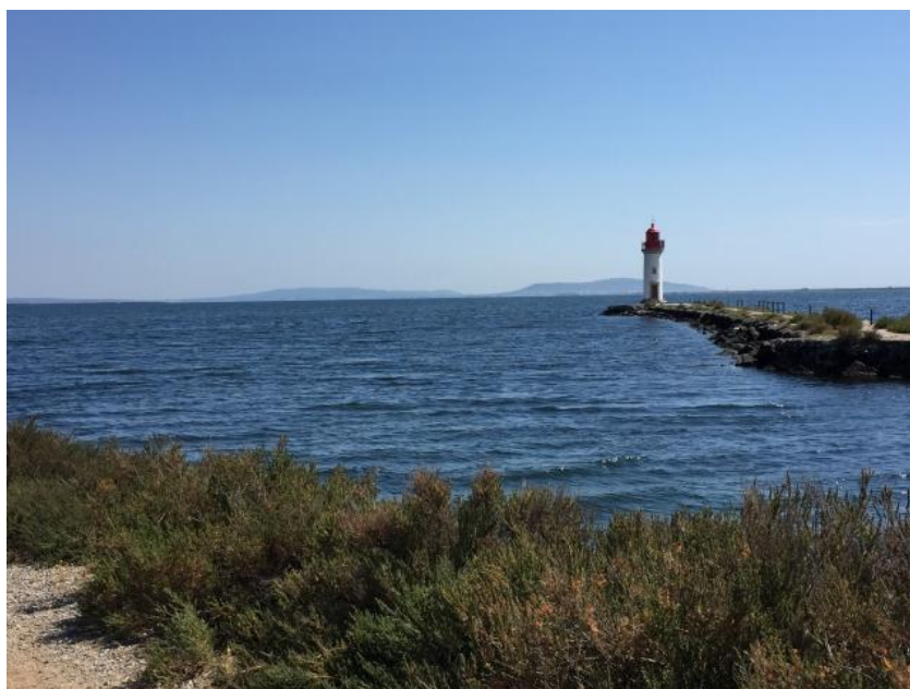
Leuchtturm an der Mündung zum Étang de Thau.
