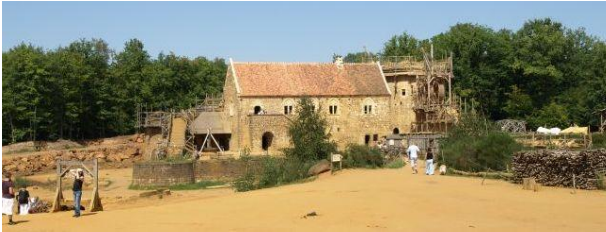
Guédelon Stand Bauarbeiten September 2011
